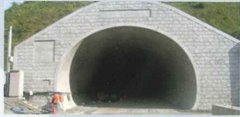
新風吹 トンネル工事
