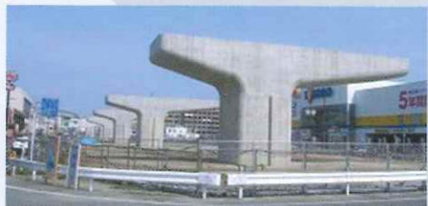
497号拾六町 高架下部工事
