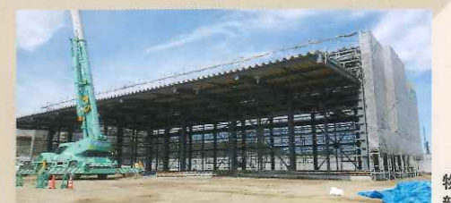
物流センター 新設工事
