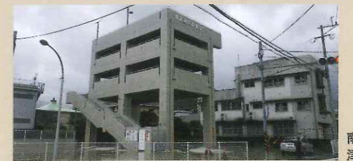
南方地区 津波避難タワー
